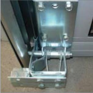
■ В конструкции ворот используются специальные устройства защиты от обрыва тросов и пружин, существенно повышающие их безопасность.
