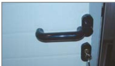
Для предотвращения несанкционированного доступа в помещение посторонних лиц, каждая калитка оснащается надёжным механическим замком, фиксация которого осуществляется при помощи ключа.
