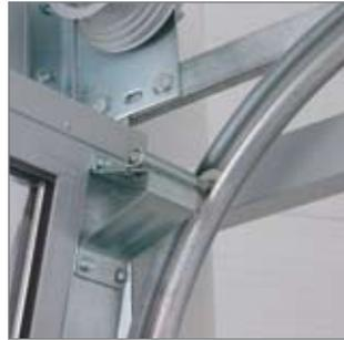
■ Все металлические профили изготавливаются толщиной не менее 2 мм, что предотвращает преждевременный выход из строя ворот при неправильной эксплуатации.
